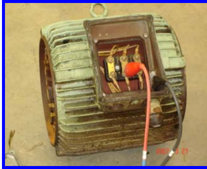
รูปที่ 5 แสดงการต่อสายเพื่อวัดค่าความต้านทานฉนวน
