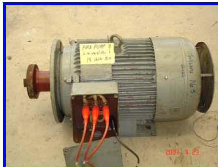
รูปที่ 10 แสดงการต่อสายเพื่อทดสอบ SURGE TEST
