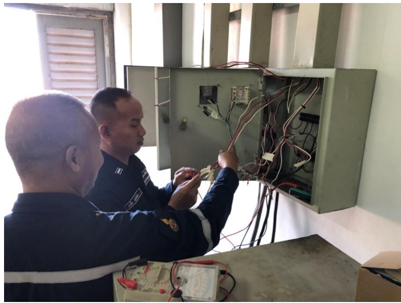
การทดลองระบบฯ โดยใช้โปรแกรม PLC ในการควบคุมและแจ้งเตือน
