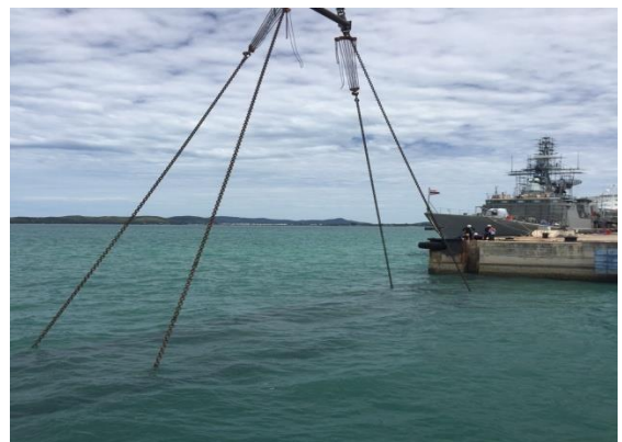
การยก SG. ชุดที่ ๑๐ ลงไปติดตั้งเป็นชั้นแรก
