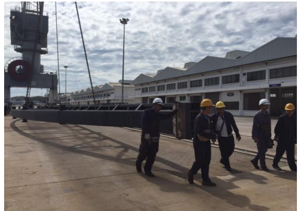
การเคลื่อนย้าย SG. โดยใช้เครนประจำอยู่ (เครนไฟฟ้า) ยกขนานมากับรางเครนไฟฟ้า
