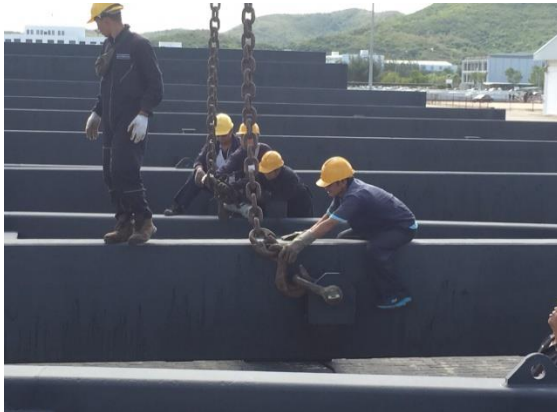
การปรับแต่งหาระดับ SG. ก่อนเคลื่อนย้ายไปติดตั้ง
