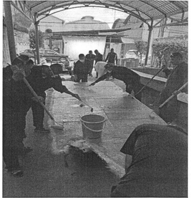
- ลงชั้นใยแก้วพื้นตาดฟ้า ประกอบด้วย Csm 300 Csm 450 และ Wr 800
